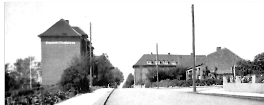
Sygehusvej. Til venstre i forgrunden ses Aldersrenteboligerne »Bavnegård«. Til højre sygehusets administrationsbygning. Foto 1951.
