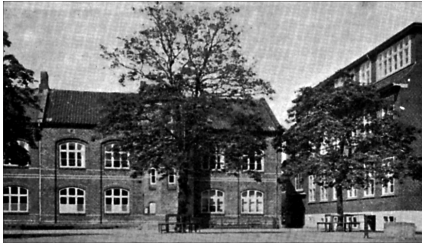
Skolebygningen fra 1867 set fra gården. Til højre ses skolebygning nr. 5 (opf. 1938). Foto 1951.
