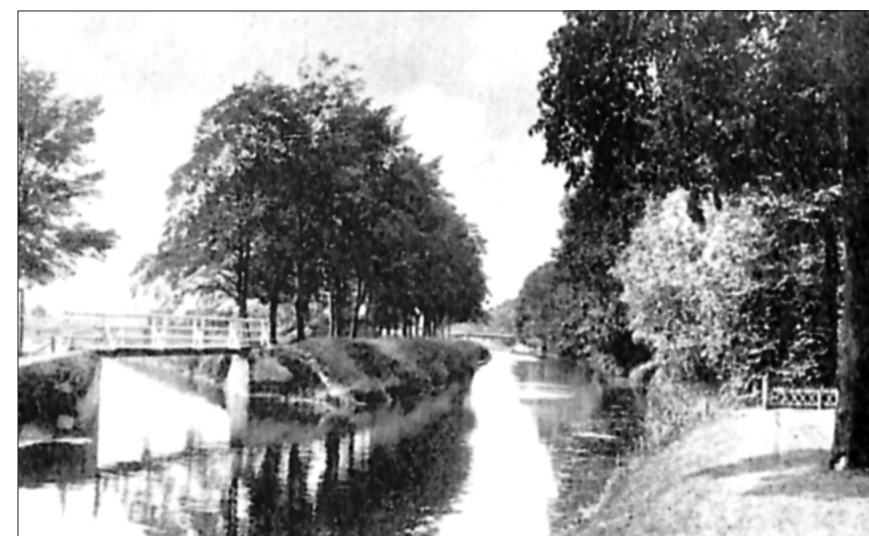
Sammenløbet ved Grenå mellem Gammel Å og den i 1873 i anledning af sundets udtørring gravede nordkanal.
