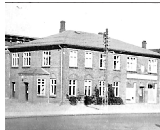
Grenå Andels-Svineslagteri. Kontorbygningen mod Østerbrogade opført 1904. Foto 1945.
