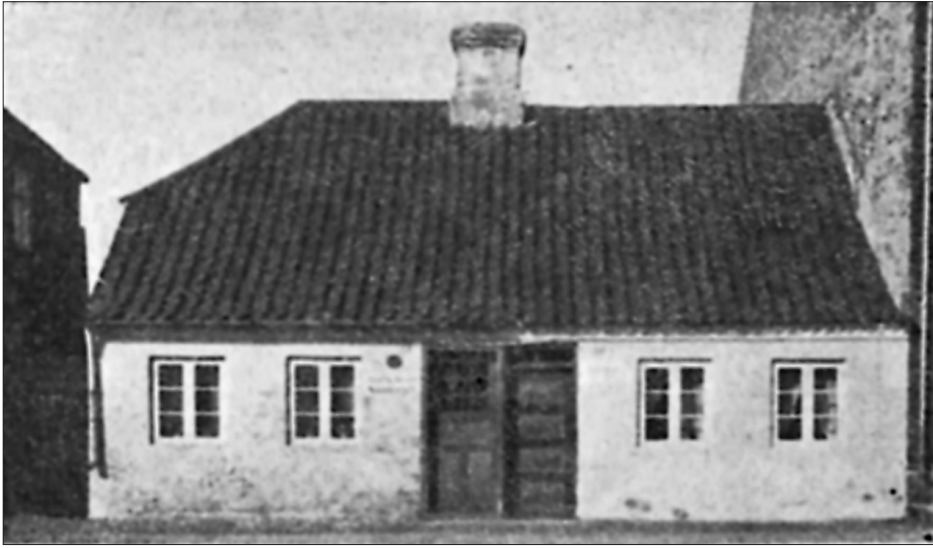
Strandgade nr. 14 og 12, som byggedes i 1849 af fisker J. F. Dabelsteen. Han beholdt selv de østre 2½ fag nr. 12 (nu grønthandler N. Johnsen), og frasolgte straks efter opførelsen de andre 2½.fag, nr. 14, til fisker Matthias Andersen (nu cyklehandler Viggo Jensen).
