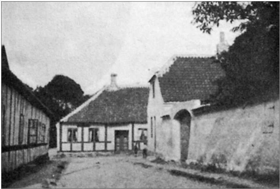
Mellemstræde. Urmager Valeurs gavl, port og sidebygning, opført 1853.
