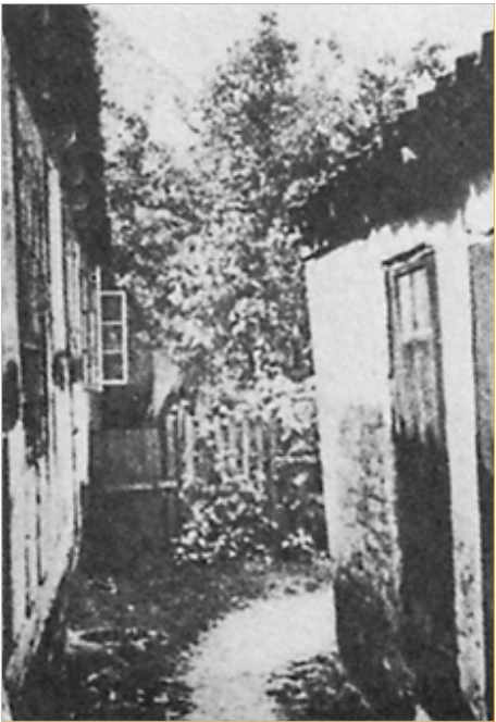
Den lille morsomme smøge mellem farvehandelen og naboen. Egebindingsværket til venstre viser tydelige spor af, at det i sin tid må have flyttet til den nuværende plads fra en ældre bygning.
