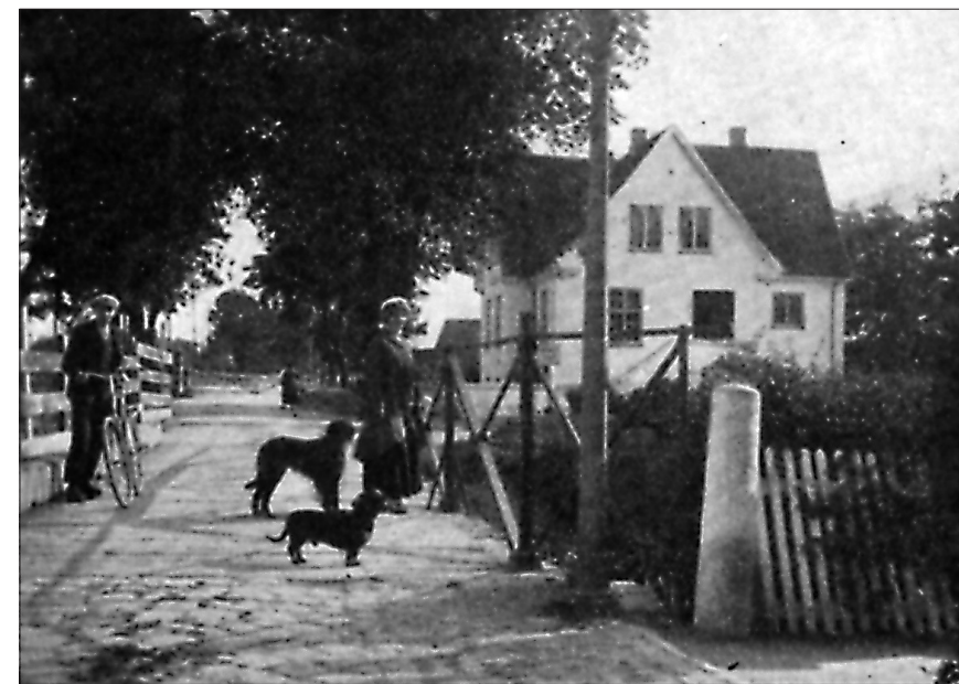
Den gamle træbro over åen, som i 1916 ombyggedes og erstattedes med den nuværende betonbro.
