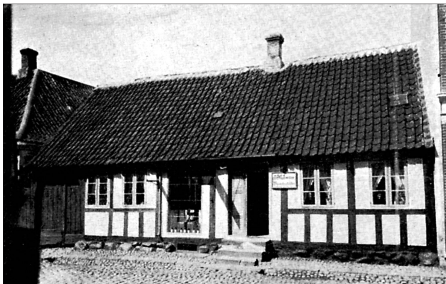
Storegade nr. 14. Huset opført i 1777 af bager Lange. Nedrevet og genopført år 1897.
