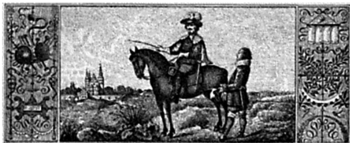
Christian IV. tilhest i Samtale med en Ingenieur. I Baggrunden Rosenborg. Efter Maleriet paa Rosenborg.
