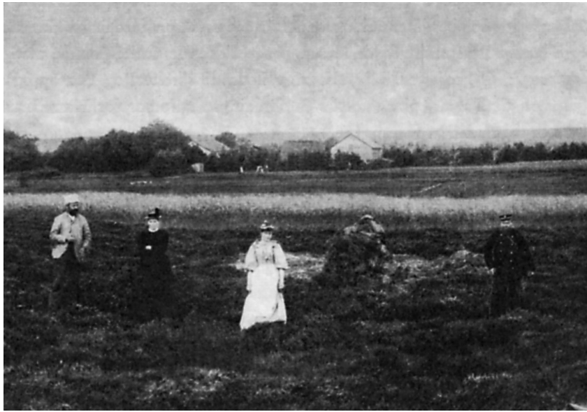
Paabølgaard ca. 1900. Til venstre står Mads Holt og bustru. Lyngtørvestakken midt i billedet fortæller om, at man endnu på dette tidspunkt brugte lyngtørv til randsel.
