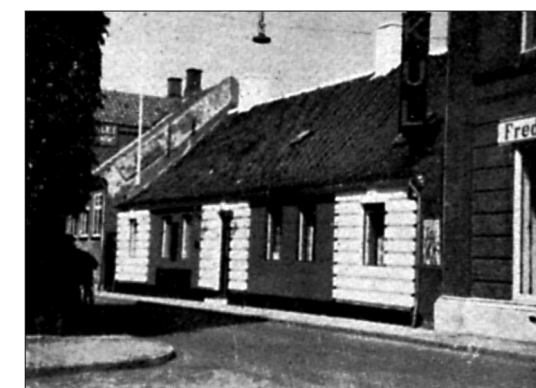
Administrationsbygningen på Mogensgade, som købtes for 31.000 kr. og var i Brug fra 1923-39. Administrationskontorerne var før den tid i den gamle realskolebygning paa Lillegade fra 1915 til 1923, da bygningen omdannedes til De gamles Hjem.
