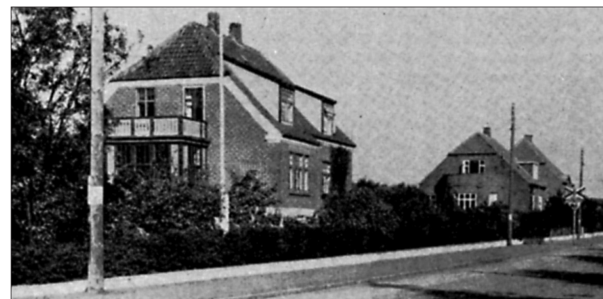
Åstrupvejen efter den nye vejs anlæg. (Foto 1944).
