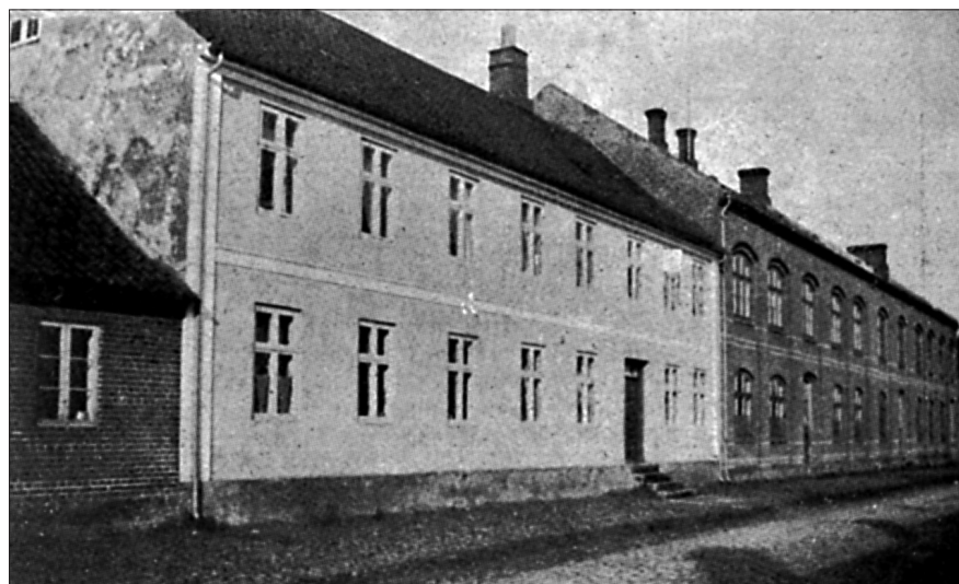
De tre ældste skolebygninger på Vestergade. Længst til venstre ses et fag af den gamle jordemoderbolig. Dernæst 1) Bygningen fra 1849. Den er nu nedrevet, og den nye skolebygning fra 1938 er opført på grunden. 2) bygningen fra 1867 (den ældste af de nu eksisterende bygninger). 3) Skolebygningen fra 1887, Som er helt sammenbygget med nr 2.
