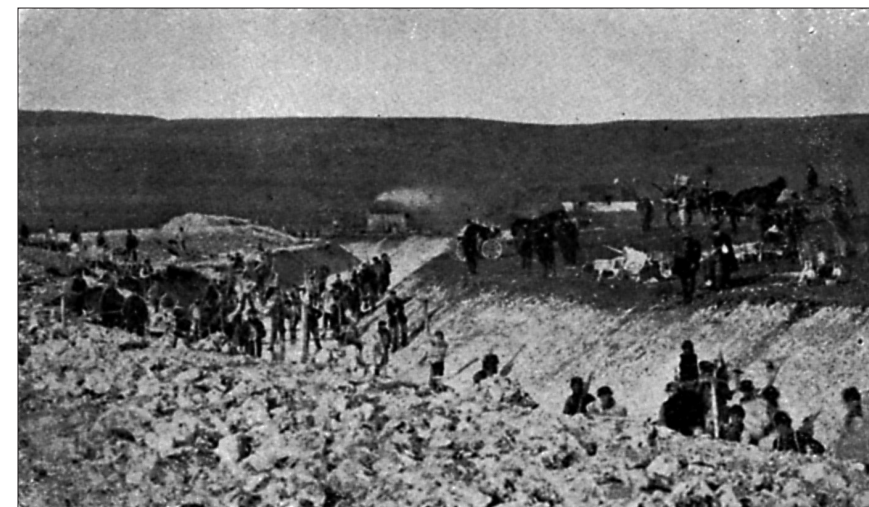
Under kanalarbejdet ved Kolindsunds udtørring 1873. Billedet er taget tæt ved Enslev. I aggrunden ses til venstre en lille strimmel af Djursgård Skov. Til højre ses Buskehuset, resten af en tidligere gård. Den lille bygning i midten er marketenderiet.
