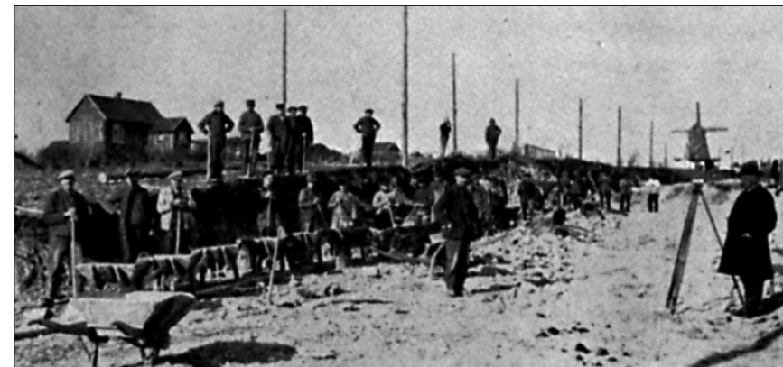
Udgravningen af Bavnhøjvejen 1931-32. Til højre ved nivellerinstrumentet står gade- og vejinspektøren.
