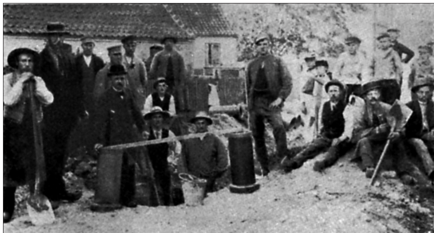
Kloakarbejde i Kannikegade. I forgrunden med hånden på kloakrøret ses kantor Fr. Petersen, som i en række år var formand for brolægningssudvalget.
