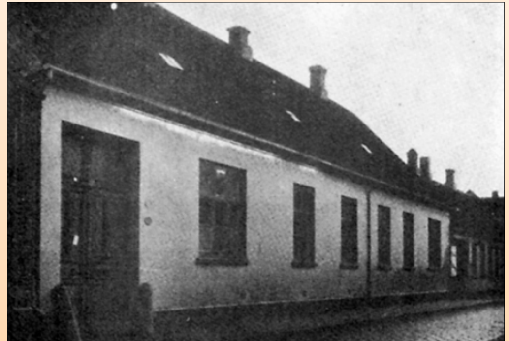
Præstegården - Storegade 34 inden ombygningen.
