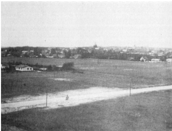
Blikkenslagermester Jens O. Johansen tog en række billeder under gymnasie-byggeriet, disse to fra gymnasiets skorsten. Øverst ses Josiassensvej og huse ved Høgevej og udsigt ind over Sønderallé.
