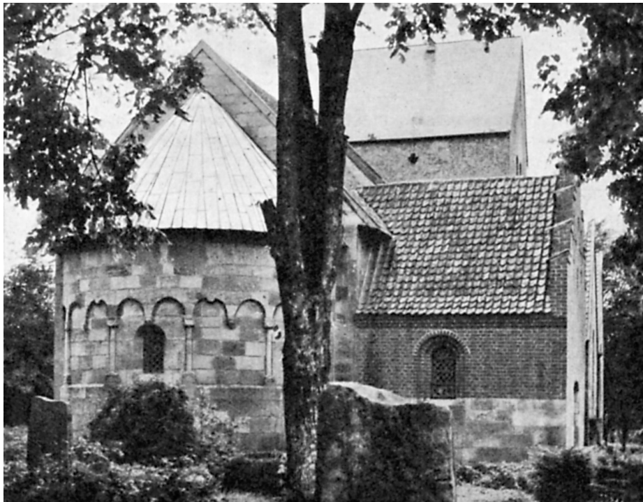
Grindeslev Kirke, et Bygningsværk fra Romanikens Blomstringstid. Foto: Jonals Co.
