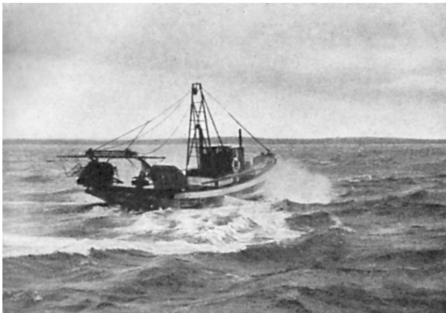
Skrabebaaden gaar ud. Paa Agterenden ses Skrabere fæstet til Bommen. Foto: M. Blegvad.
